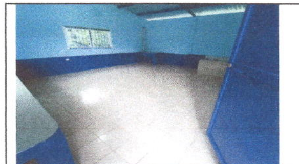
foto 5: Sustitución de piso cerámico En modulo de Cocina
