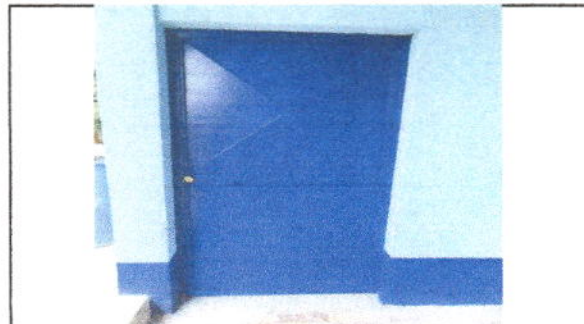
foto 3: Sustitución de puerta En modulo de Cocina
